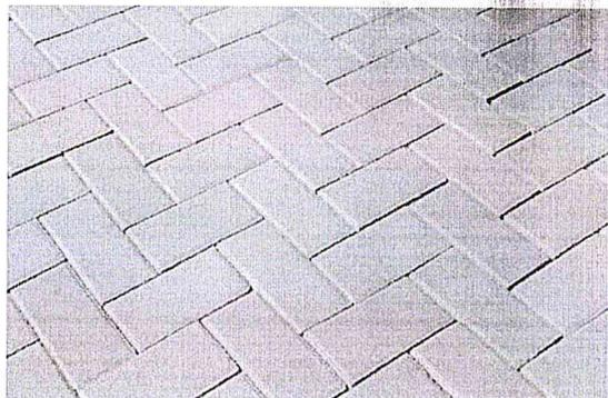
Fig. 18 – Calçamento em *paver* tipo *holland*, cor natural.
