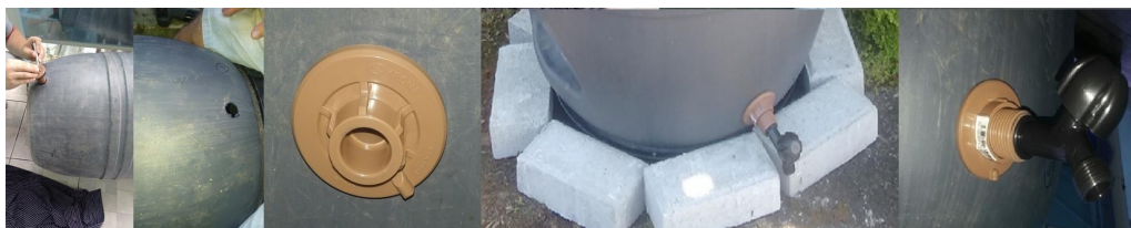
FIGURA 3. SISTEMA DE RECOLHA PÓS-FILTRO DO CHORUME.
